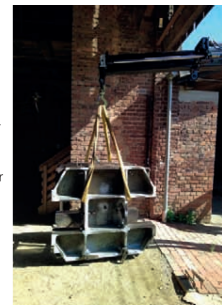
Die Anlieferung des tonnenschweren Feinwalzwerks war ebenso ein Drahtseilakt wie sein Einbau in den Mechanismus aus vielen weiteren Maschinen.
